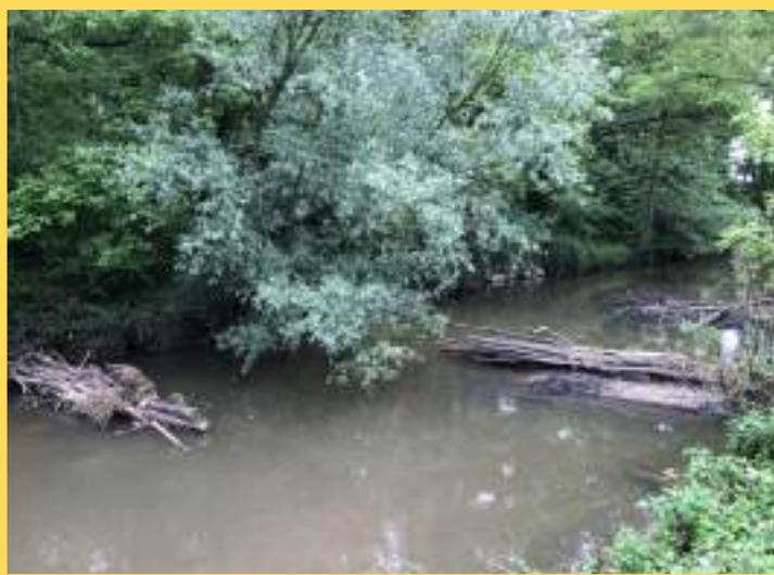
Epis de diversification des écoulements en aval du barrage des Îlons - Source : SRDCBS
